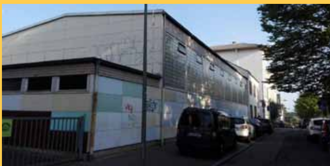
Die marode Turnhalle soll abgerissen werden.
